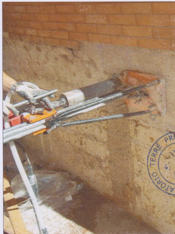
Postazione carotaggio Trave (C3)
