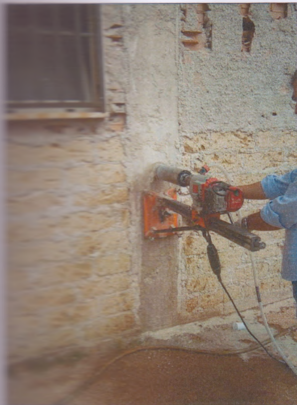
Postazione Carotaggio Pilastro (C1)
